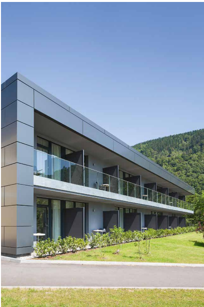
Abb. 11: Der neue Hotel-Zubau kontrastiert mit dem denkmalgeschützten Biedermeier-Bestand (© Mark Sengstbratl)
