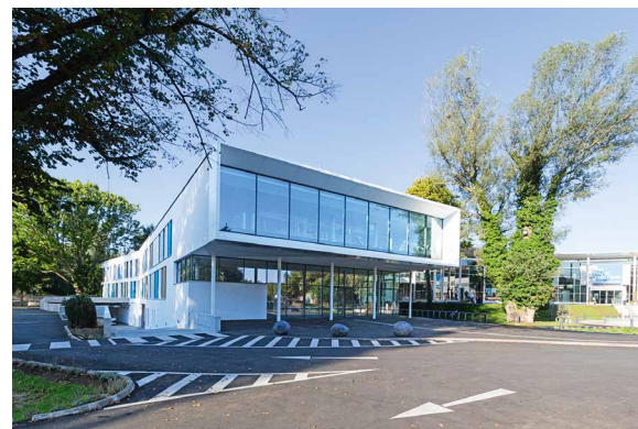
Abb. 1: Der Haupteingang des Therapiezentrums ist durch den auskragenden Trainingsraum witterungsgeschützt (© skyline architekten)
