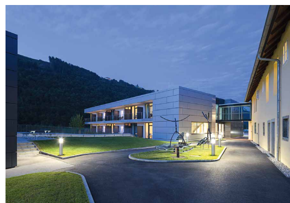
Abb. 10: Im Innenhof, der sich zur Donau öffnet, kontrastieren Altbestand und Neubauten (© Mark Sengstbratl)
