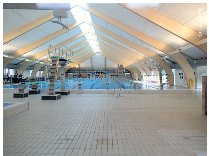
Der Innenraum der Schwimmhalle nach der Sanierung mit dem sehr gut gedämmten Satteldach und dem Oberlicht im Dachfirst
