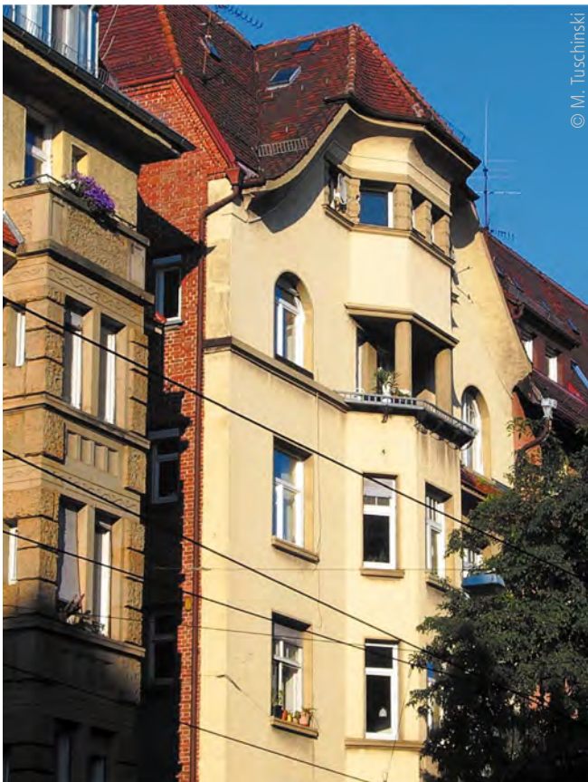
Abb. 2: Für bestimmte Öl-, Gas- oder Kohleheizungen regelt das GEG ab welchen Fristen man sie nicht mehr betreiben oder neu installieren darf
