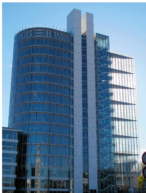
Abb. 2: Seit dem 01.01.2023 erhöht das geänderte Gebäudeenergiegesetz (GEG 2023) den Neubaustandard
